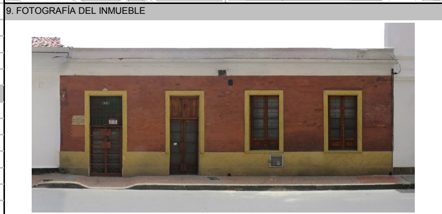
Fuente: Equipo Fotografía PEMP Patrimonio Inmueble
